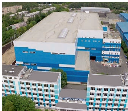
Завод «Криогенмаш», Московская область Мультизональные системы MVS DANTEX
