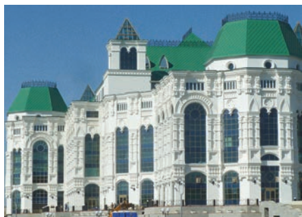
«Театр Оперы и Балета», г. Астрахань Сплит-системы большой производительности DANTEX
