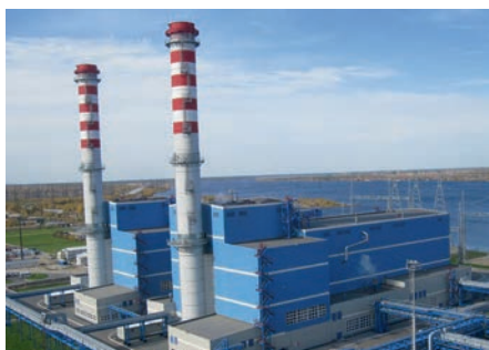
Нижневартовская ГРЭС, г. Нижневартовск Мультизональные системы MVS DANTEX
