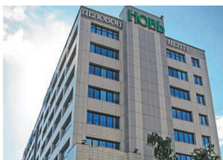
Бизнес-Центр «НОВЬ», г. Москва Мультизональные системы MVS DANTEX
