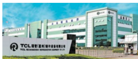
6 Завод СП «TCL – Reichi Compressor» (16 млн. компрессоров для кондиционеров)
