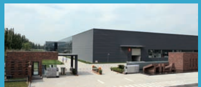
Производственная база в Тяньцзине
